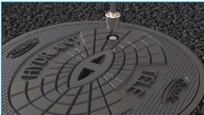
Betätigungsschlüssel aufsetzen.
